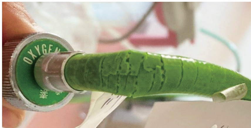
劣化したパイピングスタンドホース
