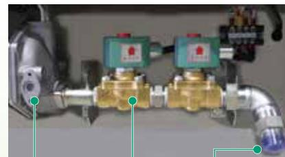
レギュレータ 二連遮断弁 ガス配管接続口R3/4
